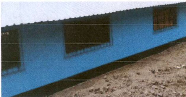
Foto 5: Pintura en muros exteriores
