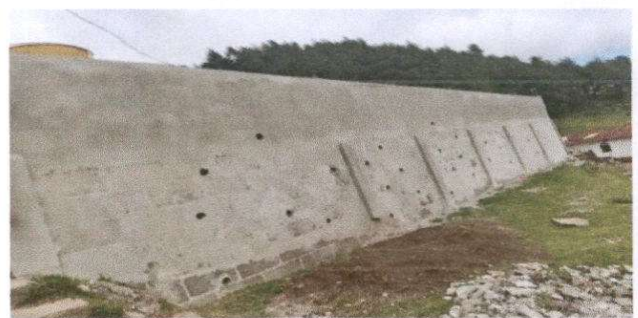
Foto 6: Reparación de muro
