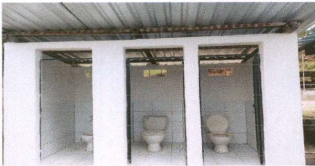
Foto 3: Sustitución de piso por cerámica
