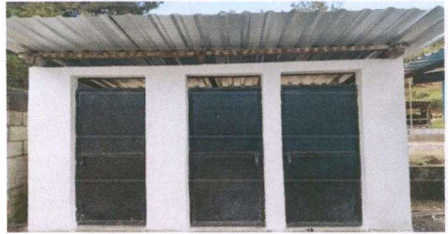
Foto 4: Sustitución de Puertas
